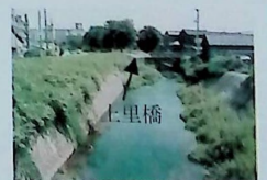
改修前の底喰川(現公民館前)
