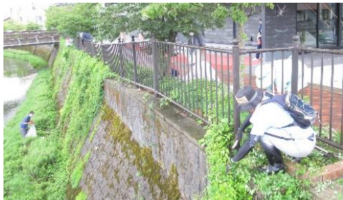
高水敷や法面の雑草取りの様子
